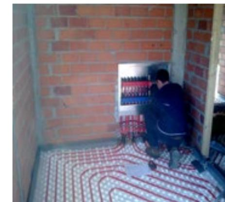
Las instalaciones de suelo radiante aseguran un confort ideal, proporcionando calor uniforme sobre toda la superficie a baja temperatura, y un ahorro energético durante el periodo estival.
